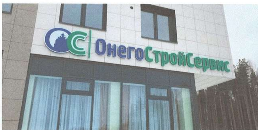
Рисунок № 2 вывеска ООО ОнегоСтройСервис на фасаде в соответствии с вопросом 3.3
